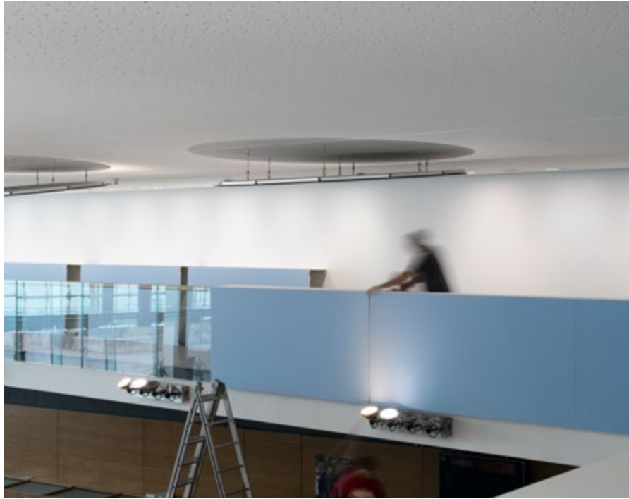
Aufbau des Sockelobjekts
